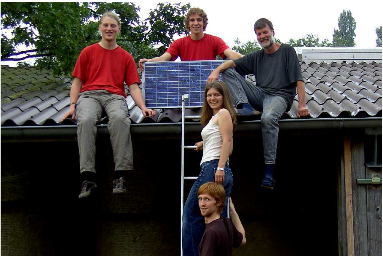
Mit einem ersten Solarmodul auf dem Dach des Gärtnerhofs Sandhausen
